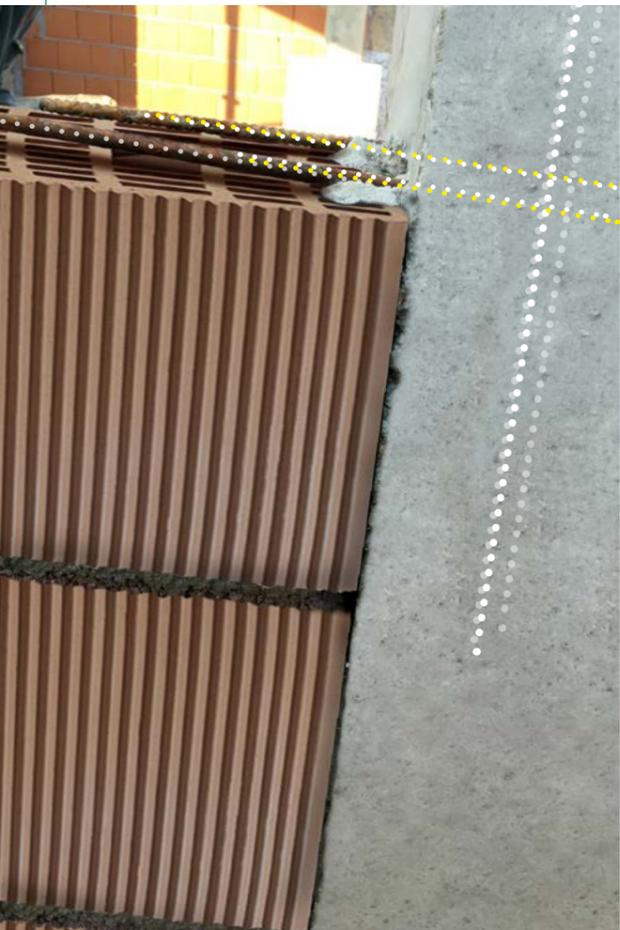
**08 |** La **struttura portante** (fondazioni a platea, pilastri e travi) sarà in getto di calcestruzzo opportunamente armato e dimensionato secondo i calcoli predisposti per zona sismica 2, D.M. 17 gennaio 2018, norme tecniche per le costruzioni, con solaio a lastra tipo Predalles.
